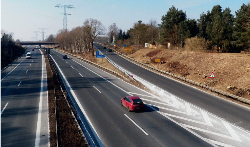
Der 6-spürige Ausbau Ortslage Birkenwerder führt zu Kahlschlag an der A 10 (Foto: T. v. Gizycki)
